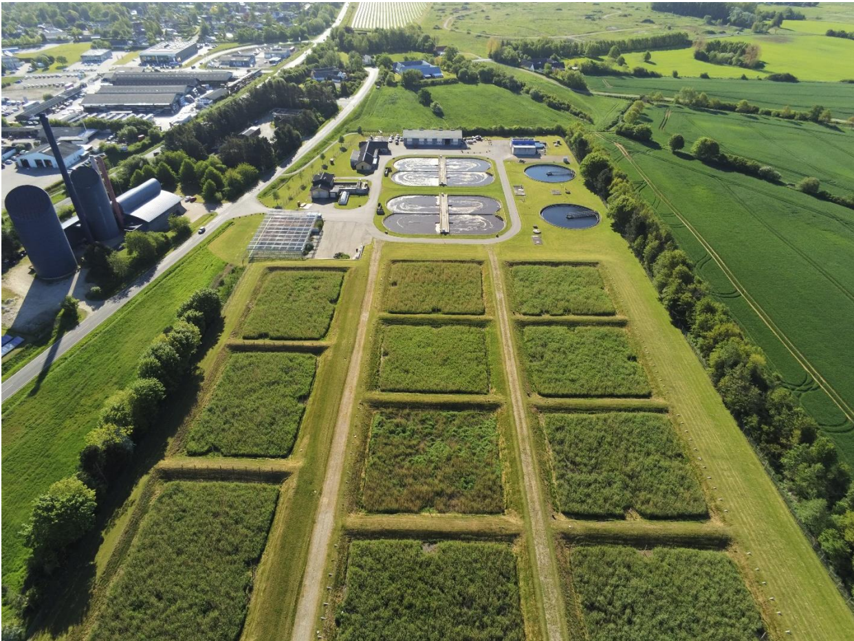
Her ses 11 ud af de 14 bede til slammineralisering på Helsingørse Slamminaliseringsanlæg.
